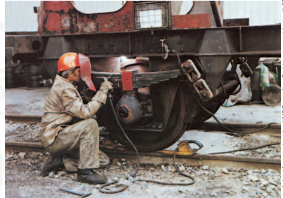
Bild 3-9: Richtig am Waggon angeschlossene Schweißstromrückleitung vermeidet Schäden am Radlager durch vagabundierende Schweißströme
