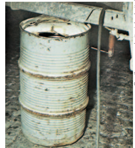
Bild 2-8: Achtlos unzulässig abgelegter Stabelektrodenhalter mit noch eingespannter Elektrode führte zur Fassexplosion
