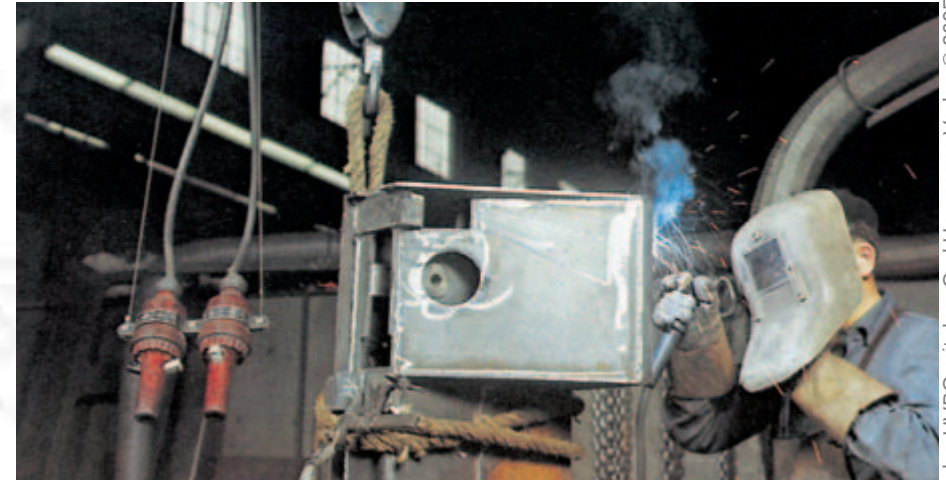
Bild 3-12: Durch trockenes Seil gegen den Kranhaken isoliertes Schweißstück
