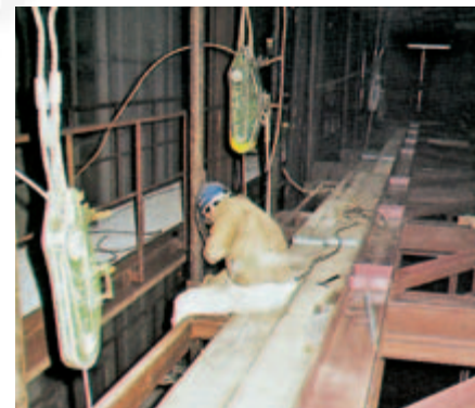
Bild 4-2: Lichtbogenschweißer unter erhöhter elektrischer Gefährdung mit unzureichender isolierender Unterlage, durch trockene Lederhose geschützt
