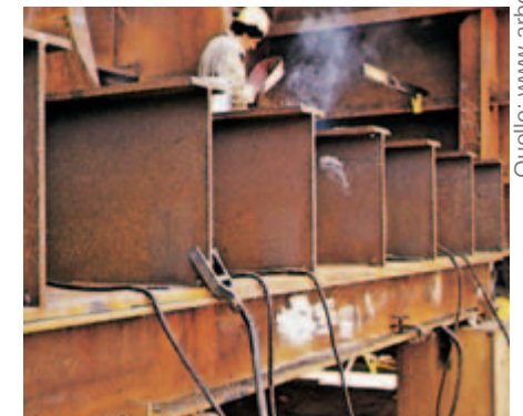
Bild 4-4: Lichtbogenschweißer unter erhöhter elektrischer Gefährdung zwischen Spanten
